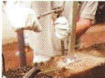
1 – Posicione os suportes no local a ser instalado, fure e faça a fixação dos mesmos.
